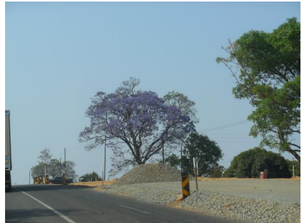
Wegwerkzaamheden waar bomen gekapt gaan worden die later weer worden teruggeplaatst
